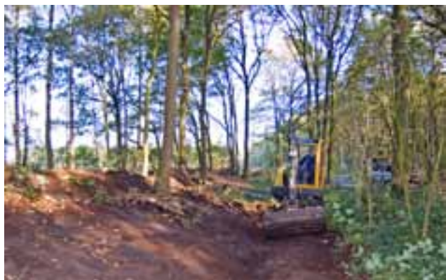
Het wallichaam is hersteld waardoor de wildgraaf opnieuw zichtbaar wordt.
