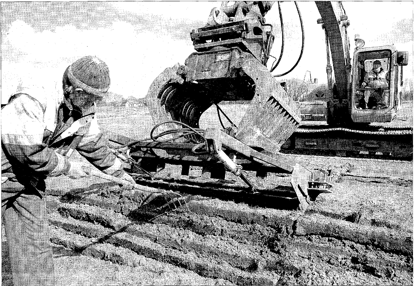
OUDESCHILD – Met een riek legt tuunwalbouwer Theo Witte een plag recht. Laagje voor laagje bouwen hij en zijn collega's op Texel een tuunwal op. De historische afscheidingen, waarvan de geschiedenis teruggaat tot 1562, worden de komende jaren hersteld. Gisteren werd daarvoor het startsein gegeven. Foto RD
